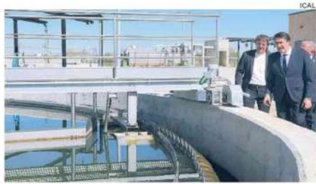
El consejero visita la depuradora de Trasmonte (Valladolid)
