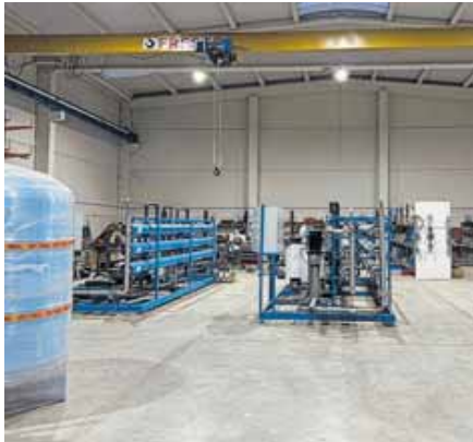
Instalaciones de la empresa Ecoytec
